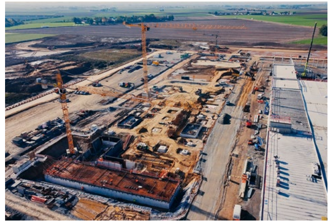
In der sogenannten „Zwischenspanne“ haben im Sommer die Bauarbeiten für die Nebengebäude begonnen
