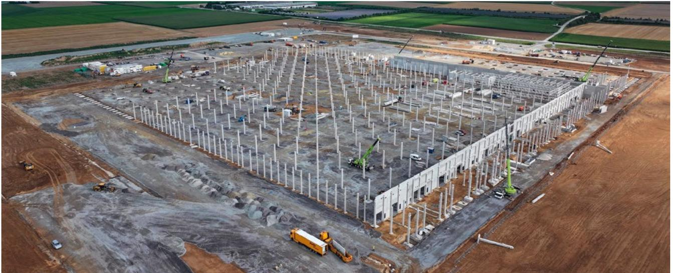
Bau des Produktionsgebäudes geht zügig voran: bis zu 100 Stützen pro Woche werden seit Hochbaubeginn aufgestellt.
