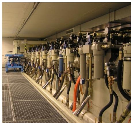
Als umweltrelevante Anlagen im Bereich „Betriebsfestigkeit und Werkstoffe“ sind zwei zentrale Hydraulikölversorgungen installiert, die über 140 hydraulische Prüfvorrichtungen zur Beanspruchung von Fahrwerk, Karosserie, Bauteilen/ Modulen und mechanischen Verbindungen mit Hydrauliköl versorgt.
